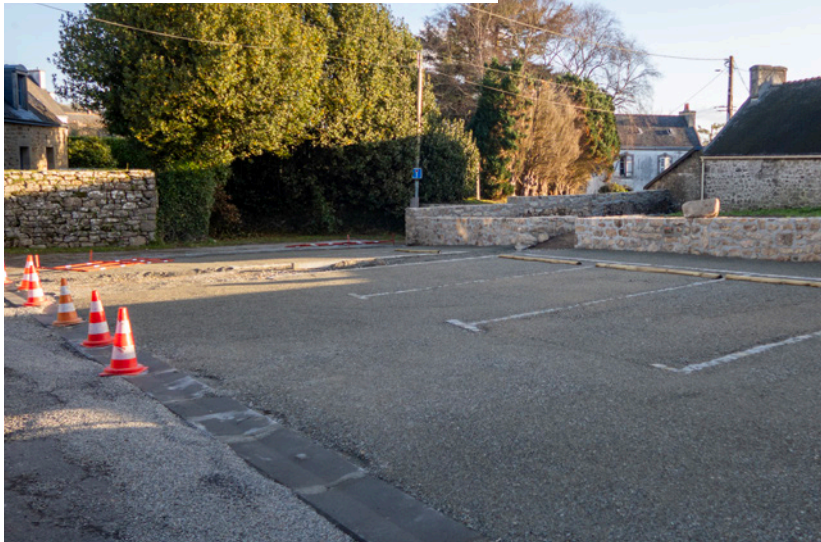
Ci-dessous et ci-contre : Restauration et création des murets de délimitation par l'équipe maçonnerie. Travaux finalisés avec création d'un caniveau pour la gestion des eaux de pluie.
