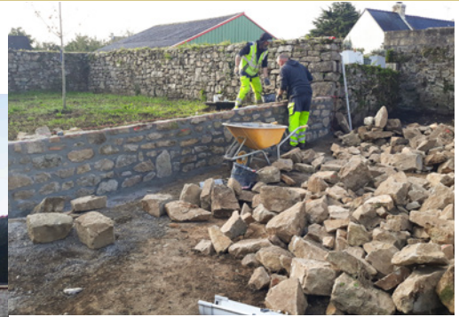
Ci-dessous et ci-contre : Restauration et création des murets de délimitation par l'équipe maçonnerie. Travaux finalisés avec création d'un caniveau pour la gestion des eaux de pluie.
