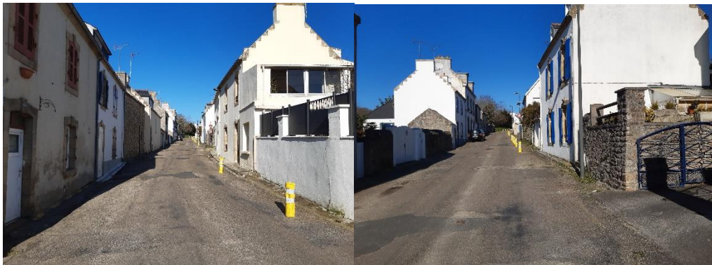
Vue générale actuelle de la voie avec cheminement pédestre de rive sécurisé par la pose de quilles J11 provisoires.
