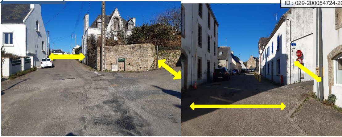
Début et fin d'emprise routière rue Gay Lussac et rue Pierre Brossolette, début et fin d'emprise routière 1ere tranche de la rue Marcellin Berthelot et entrée de la rue Hoche.
